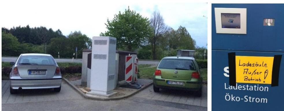
Abbildung 11: Einschränkungen durch defekte oder blockierte Ladestationen
